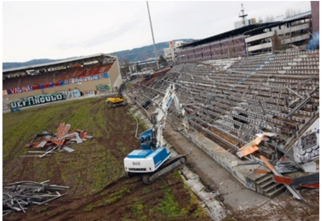
«Zwei Jahre Planung verblödet»: Abbruch des Hardturm-Stadions in Zürich.
