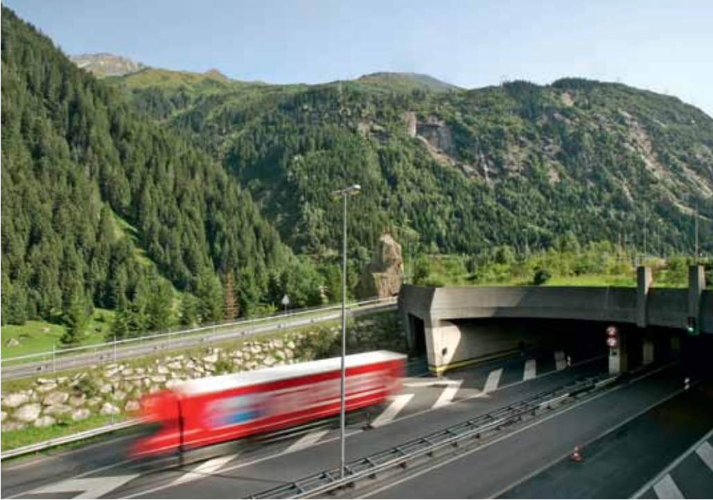
Nächste Sanierung kommt bestimmt: Gotthard-Nordportal in Göschenen.
