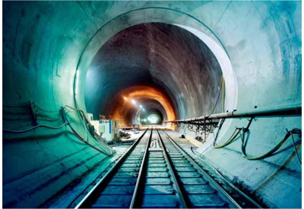
Nachweislich unkoordiniert: Gotthard-Basistunnel bei Faido TI.
