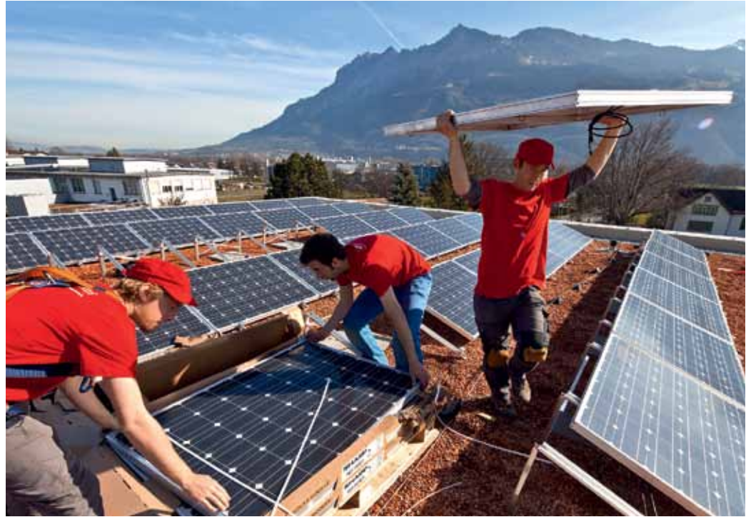
Mehr Kilowattstunden: Fotovoltaik-Anlage.
