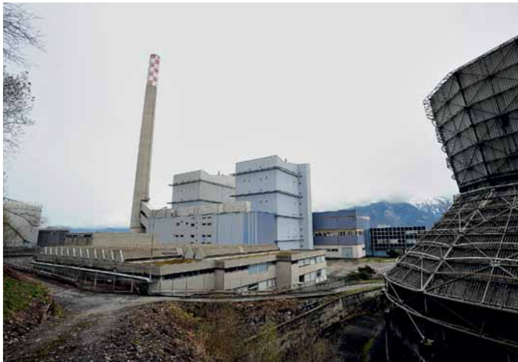
Die Weichen werden gestellt: Gaskraftwerk in Vouvry VS.
