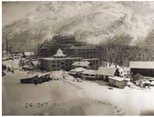
«Es arbeiten 394 Mann»: Bau des Hotels, 1911.
