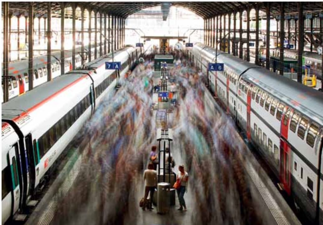
Gigantische Umwälzpumpe: Bahnhof Luzern.
