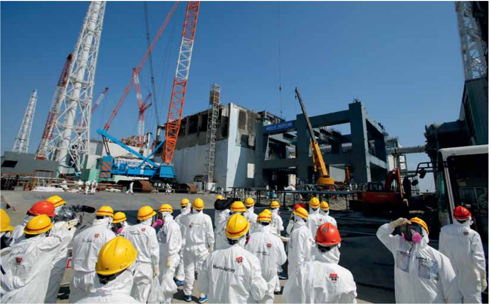
Grossbaustelle am havarierten AKW: Lokaltermin beim Reaktorblock 3 in Fukushima Daiichi.
