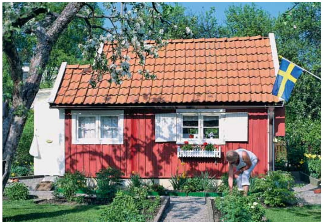
Auf brüchigem Fundament: typisches schwedisches Ferienhaus.
