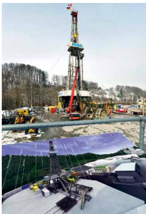
Zu nah an der Stadt: Bohrung in St. Gallen.
