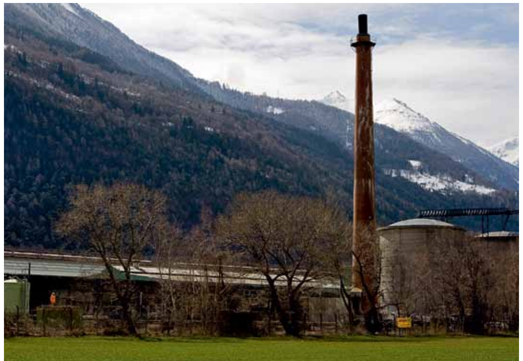
Macht des Wandels, aus alt wird neu: Sprengung des Kamins der 2006 stillgelegten Aluhütte ...
