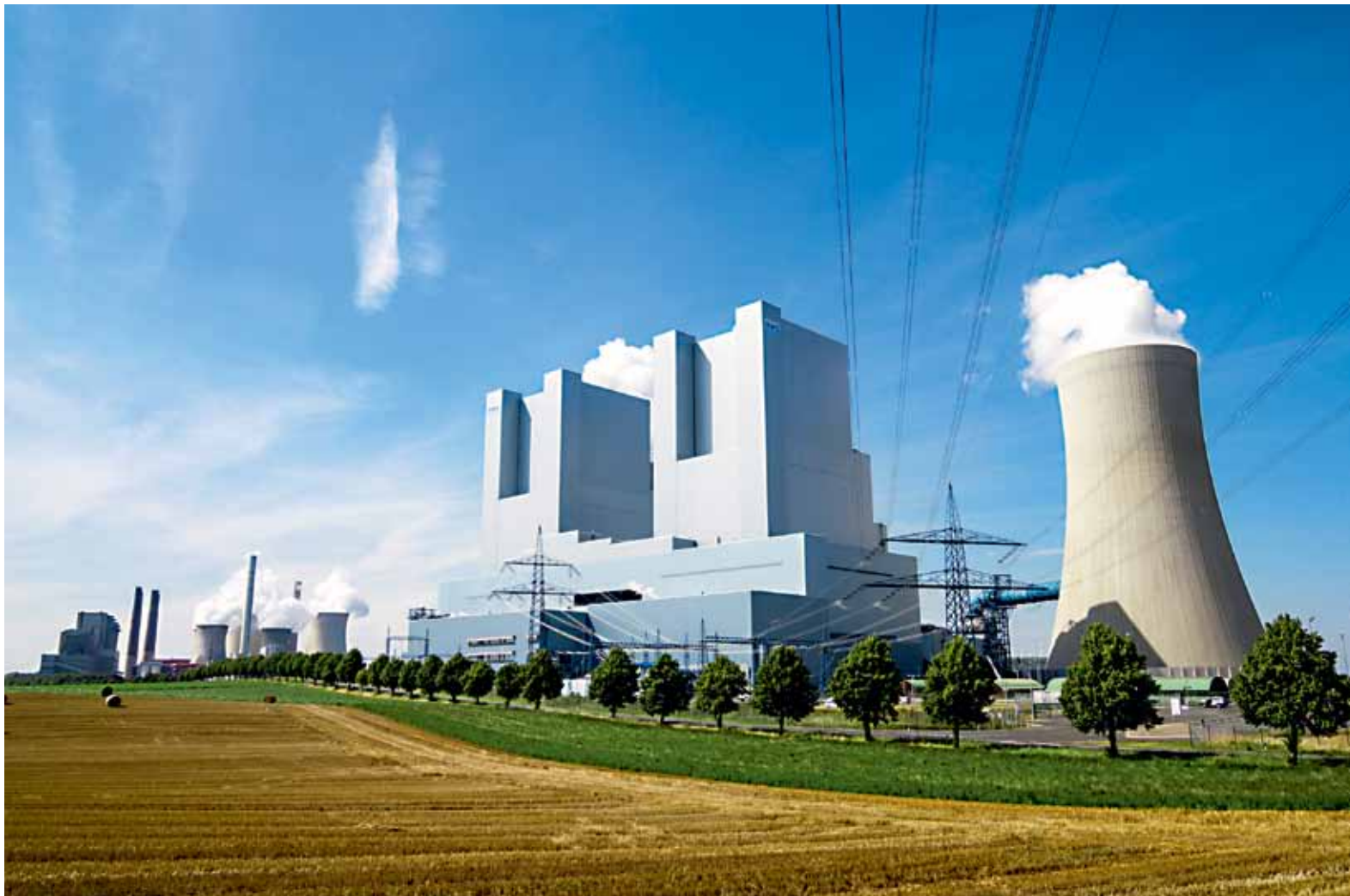
Strom für drei Millionen Haushalte: modernstes Kohlekraftwerk in Neurath, Deutschland.
