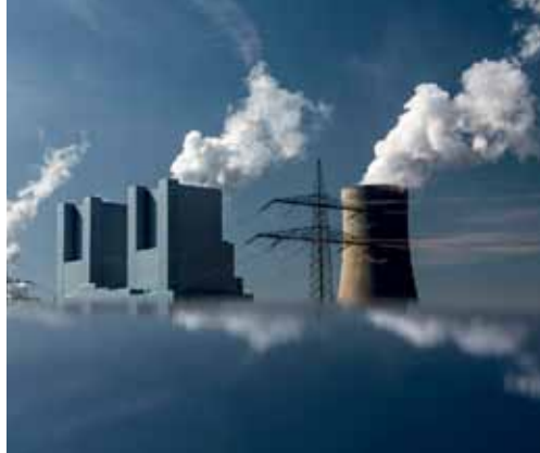
Energie der Zukunft: Kohlekraftwerk. Seite 50
