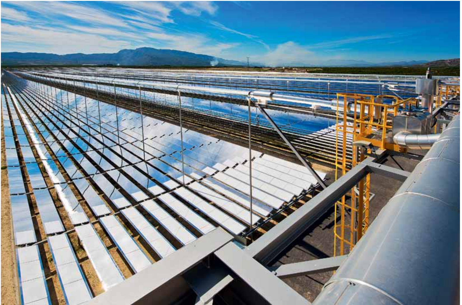
Den Kapriolen des Wetters ausgesetzt: die Sonnenspiegel des Solar-Dampf-Kraftwerkes.
