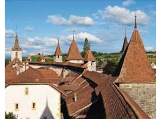
Blick über die Altstadt von Murten
