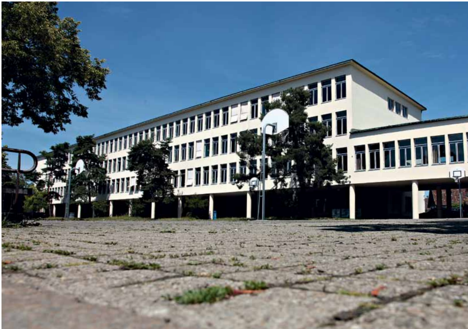
Obstruktion, Randal, Vandalismus: Schulhaus Buhnrain im Zürcher Seebach-Quartier.
