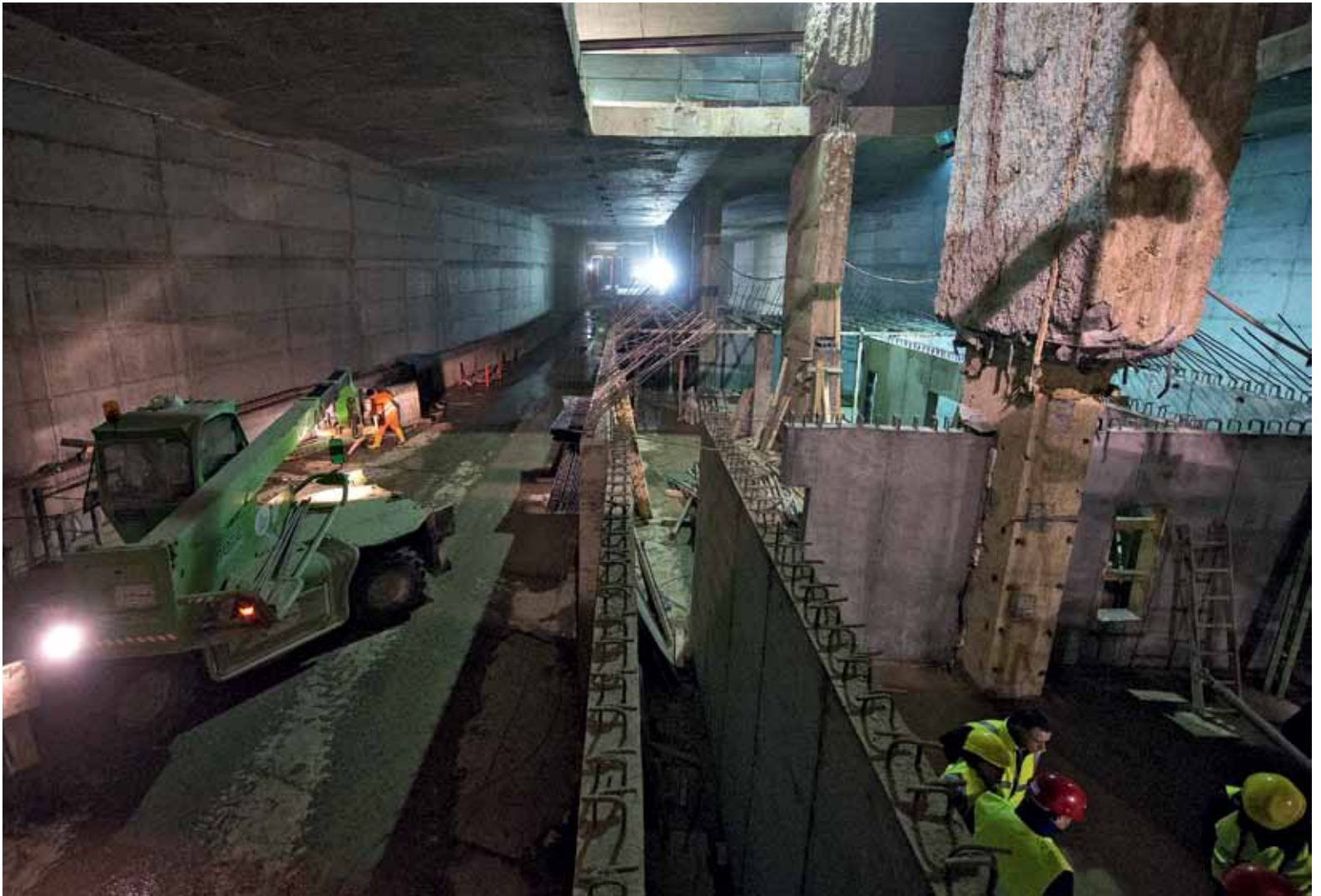
«Eine Metro, soso»: U-Bahn-Baustelle in Bukarest, 2015.
