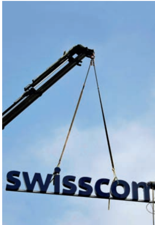
Gut aufgestellt: Medienhaus Swisscom.
