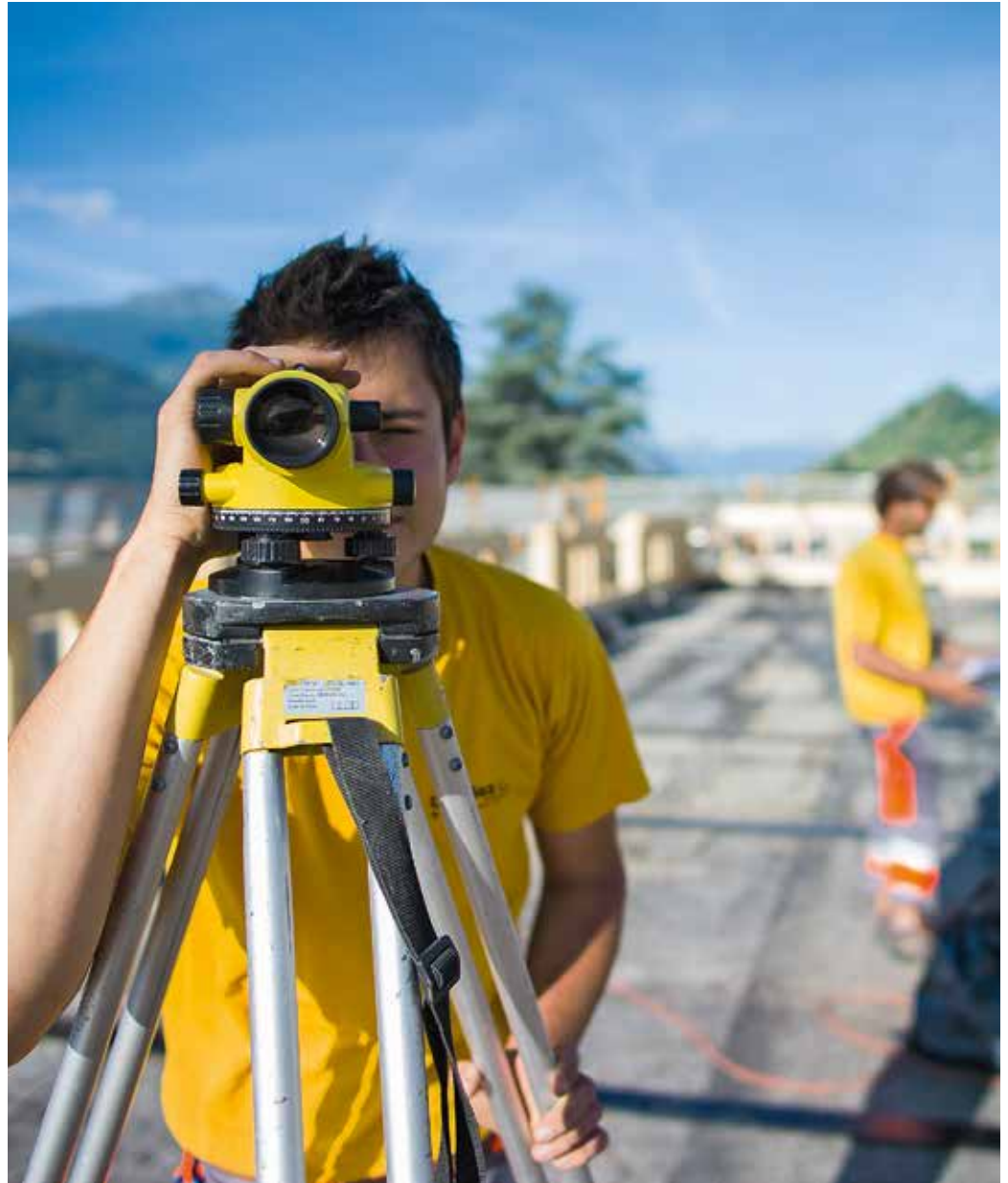
Dringend gesucht: Spezialisten auf dem Bau.
