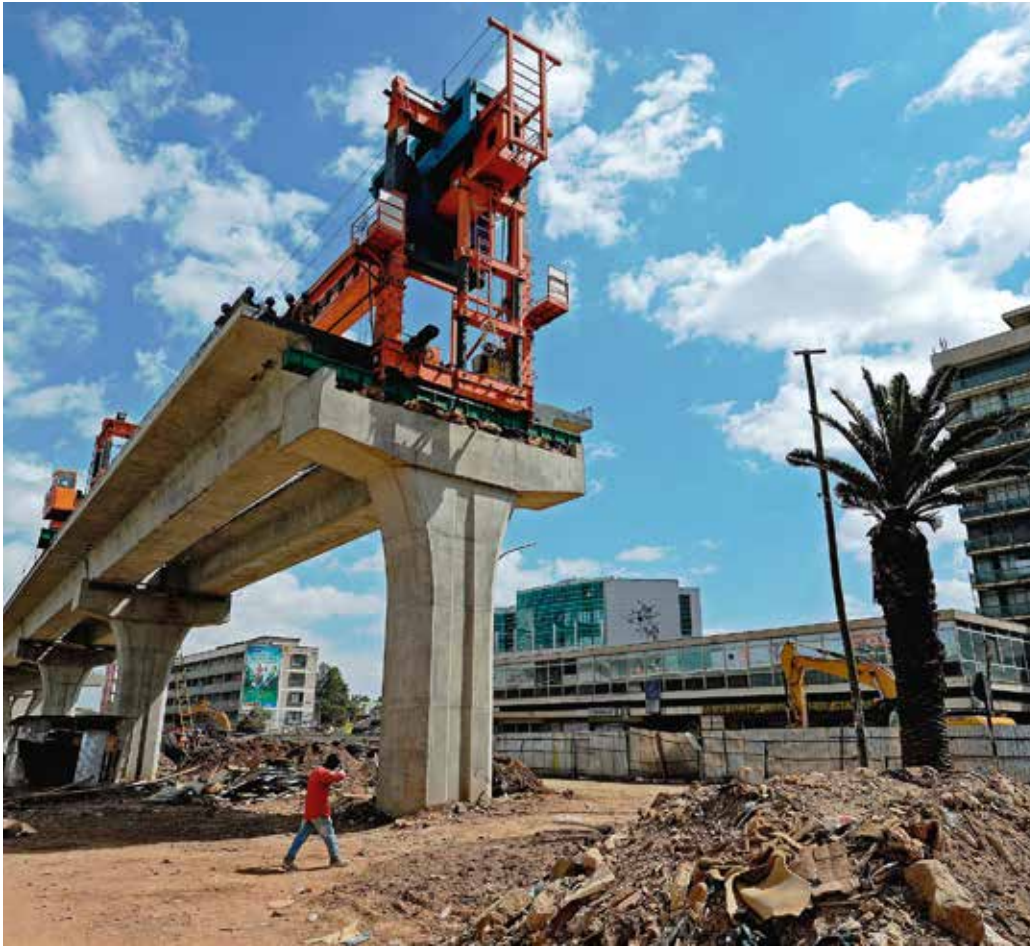
«Die Situation in Afrika hat sich in den letzten Jahren verbessert»: Bau der Stadtbahn von Addis Abeba.
