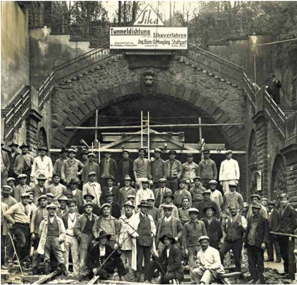
Unübertroffenes Dichtungsmittel: Bahntunnelbaustelle bei Stuttgart, 1930.
