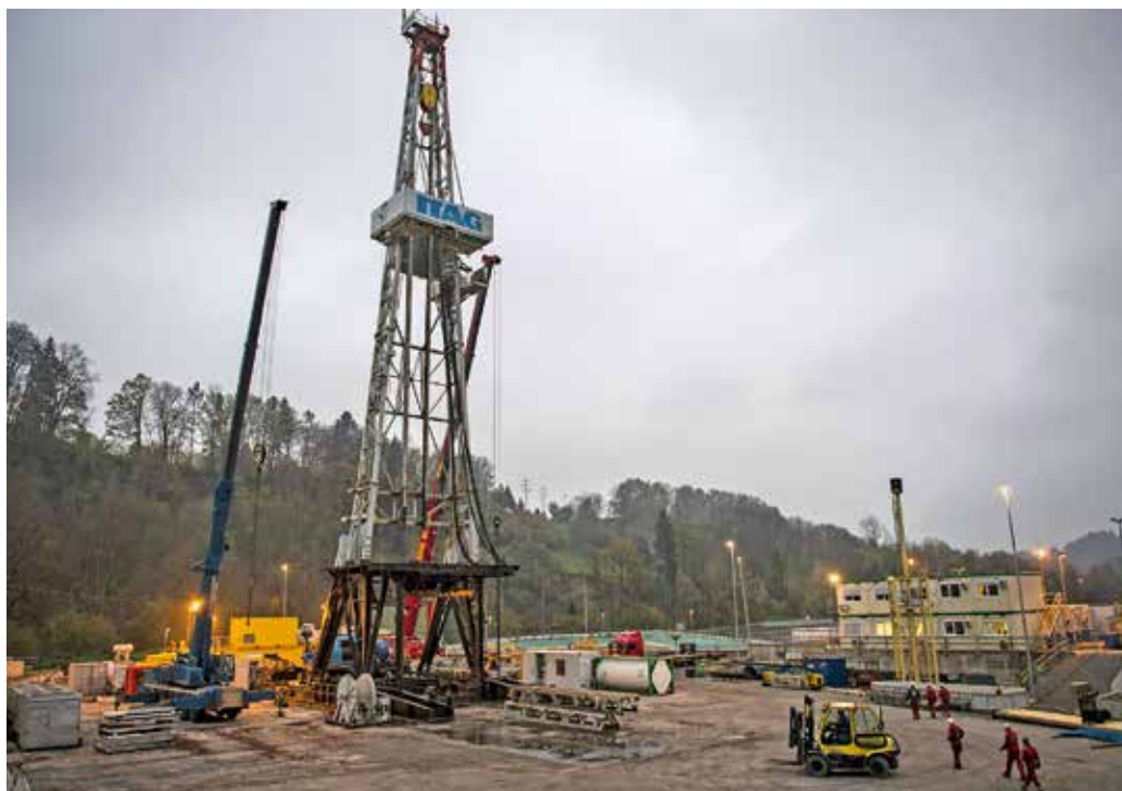
«Wunschdenken»: Bohrturm des mittlerweile gestoppten Geothermie-Projekts im Sittertobel.
