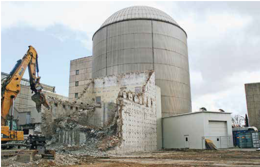
Herkulesaufgabe: Reaktorrückbau bei Karlsruhe.
