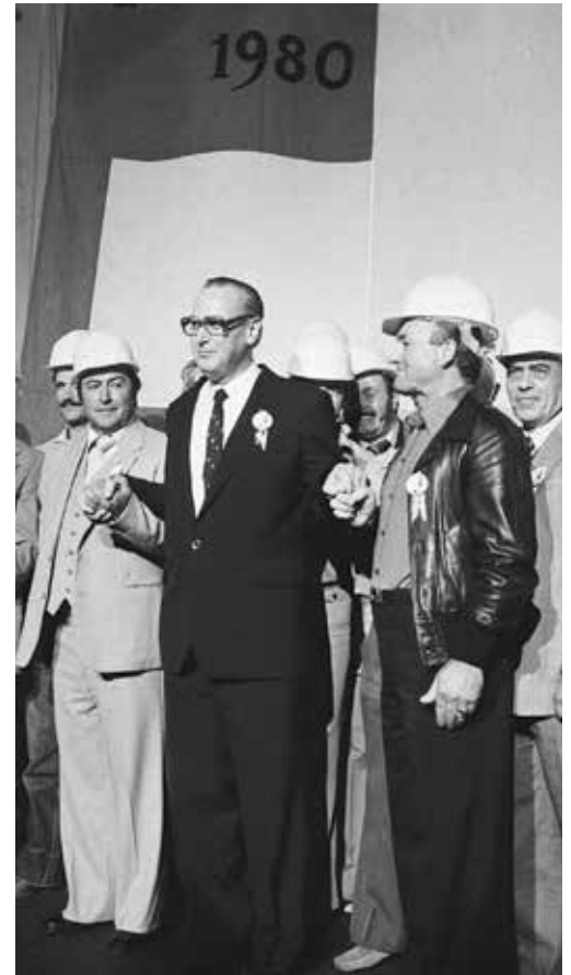
Mythos Gotthard: Tunnelöffnung. Seite 20
