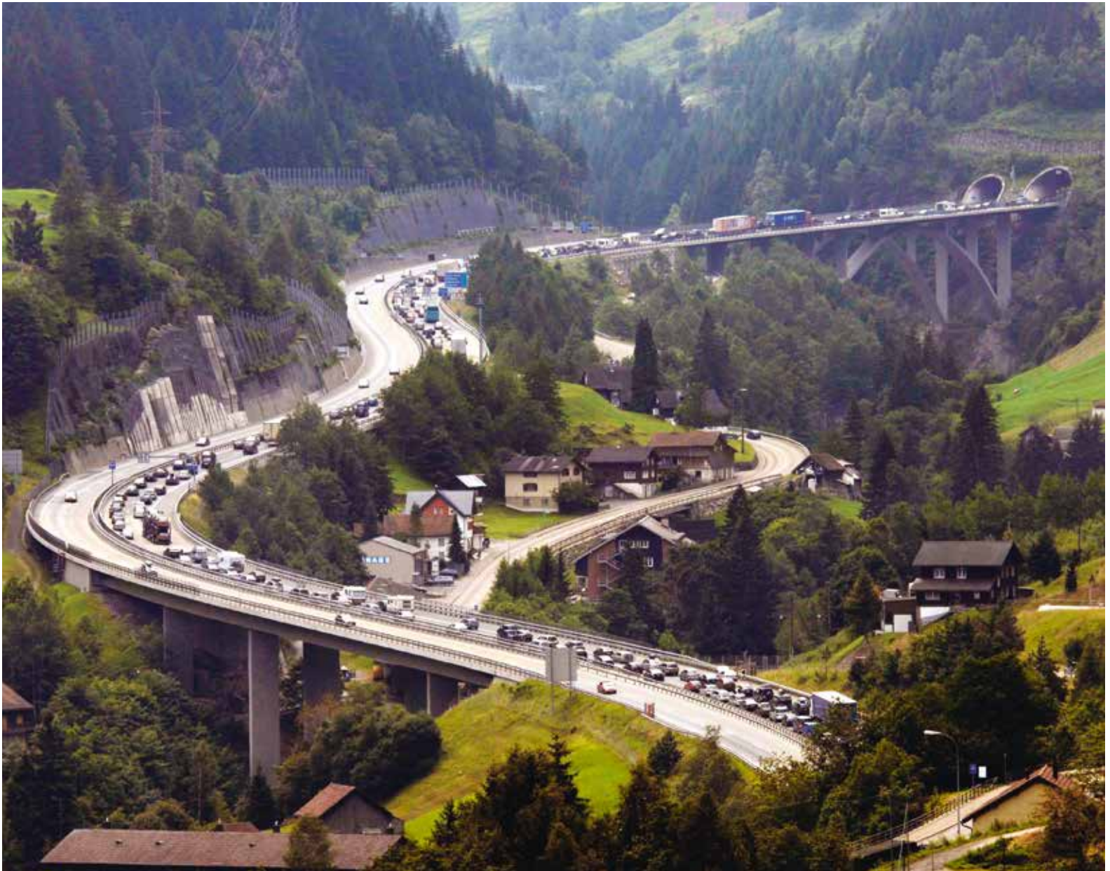
Der Strassentransit bleibt auch mit der zweiten Röhre für den Schwerverkehr unattraktiv: Gotthardautobahn.
