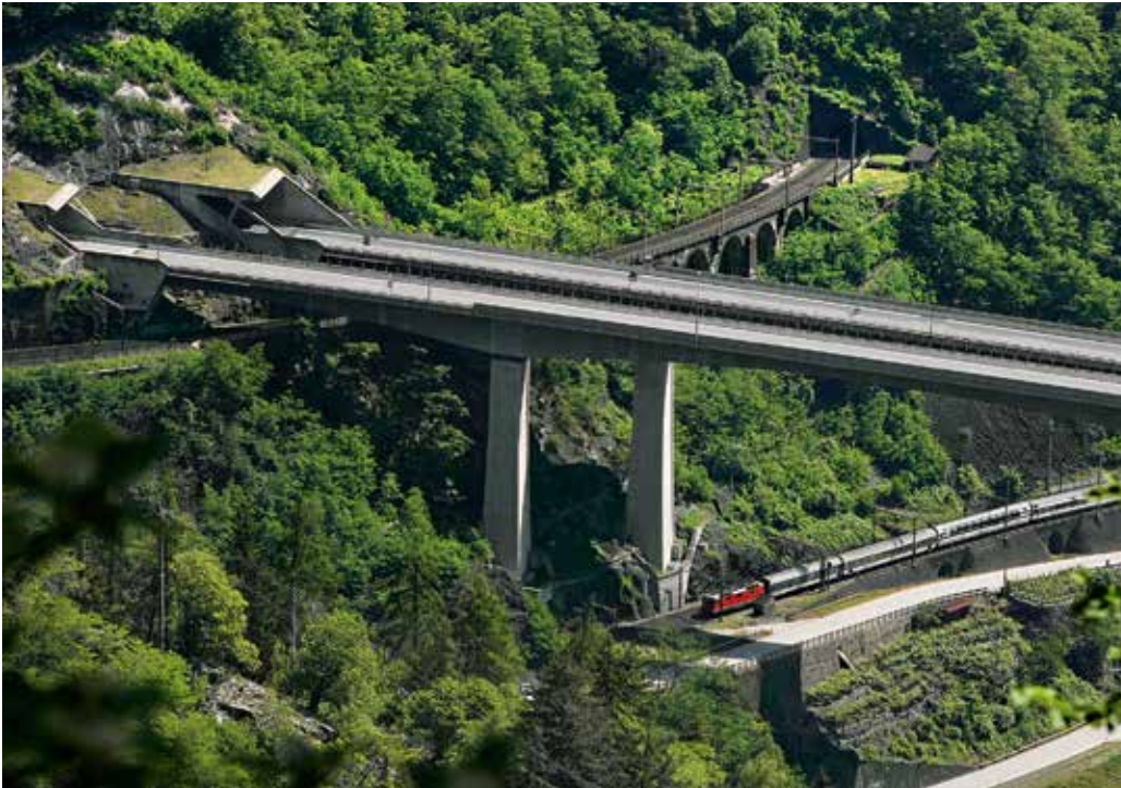
Dynamische Entwicklung: Biaschina-Viadukt an der Gotthard-Südrampe bei Giornico TI.
