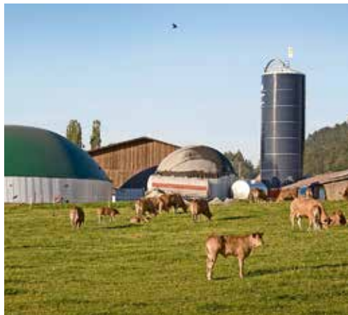
Lücke ist zu gross: Biogasanlage in Ittigen.
