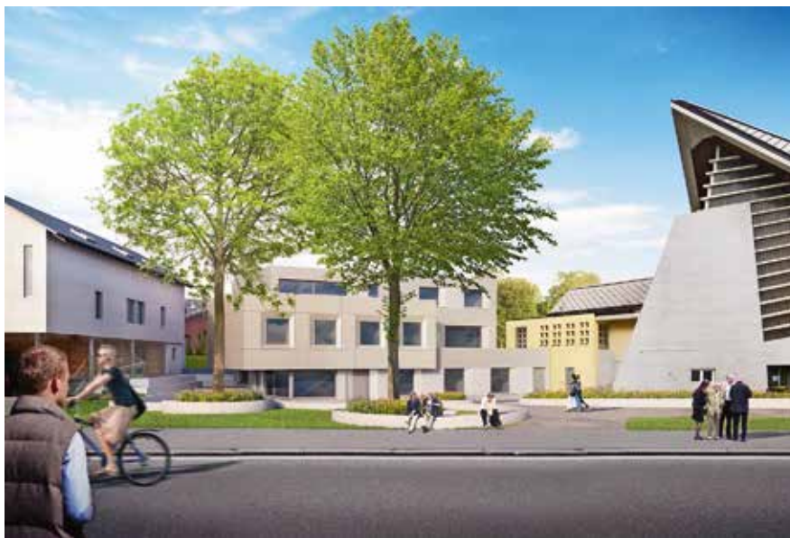
Bruttokosten von 4 982 800 Franken: neues Pfarrhaus von Pfäffikon ZH.
