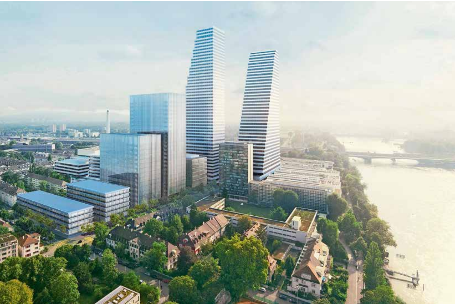
Bekanntnis zum Standort: geplante und gebaute Roche-Hochhäuser im Basler Wettsteinquartier.
