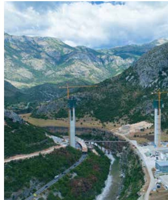
Mehr Unabhängigkeit von Brüssel: Bau einer
