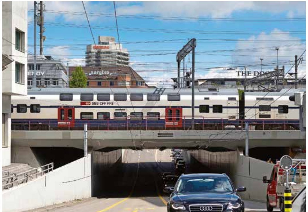
Schienenbonus: Eisenbahnunterführung Langstrasse, Zürich.
