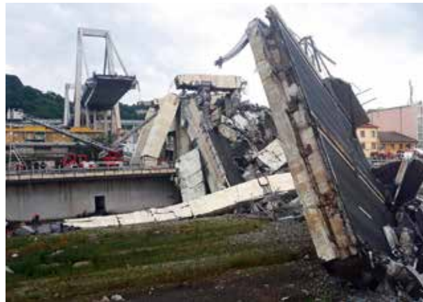
«Der Staat geht, Benetton kommt»: Morandi-Viadukt.
