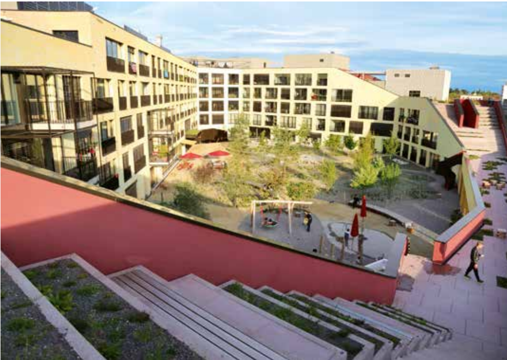
Wohnfläche pro Person reduziert: Genossenschaft Kalkbreite, Zürich.
