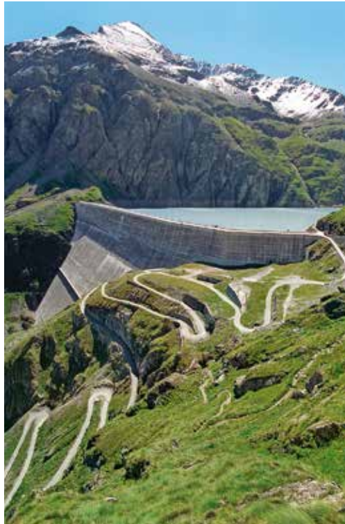
«Alpenbatterie»: Staumauer Grande Dixence.
