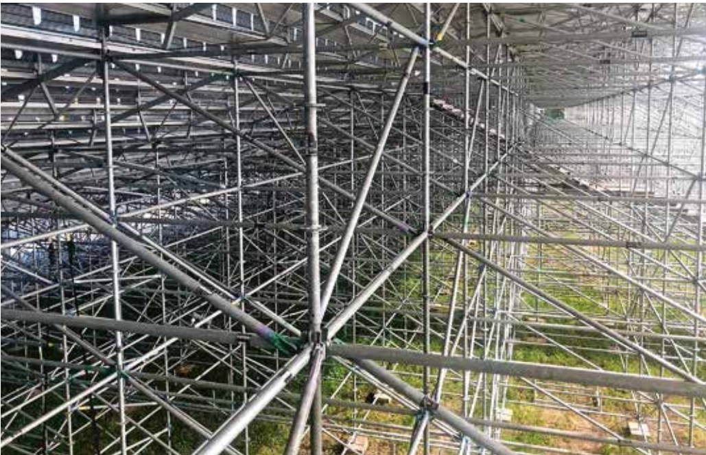
Ohne eine einzige Schraube: Tribümenteile der Firma Nüssli.
