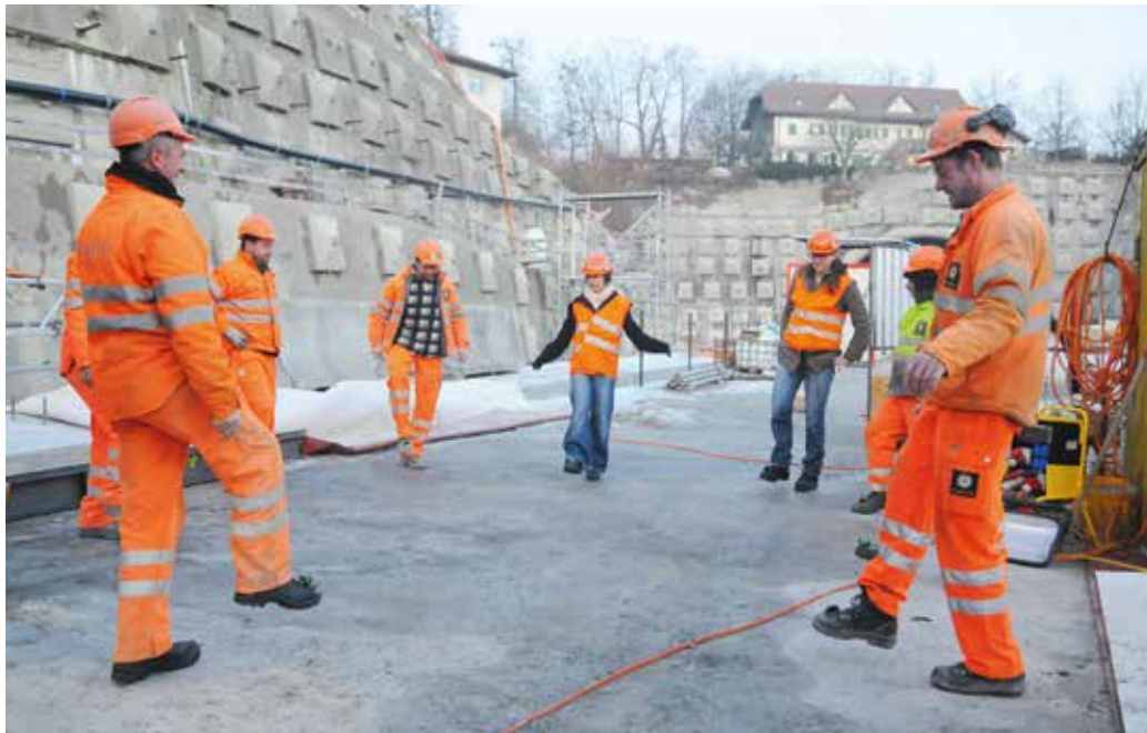
Unterschiedlich rentable Teile: Implenia-Baustelle in Freiburg.
