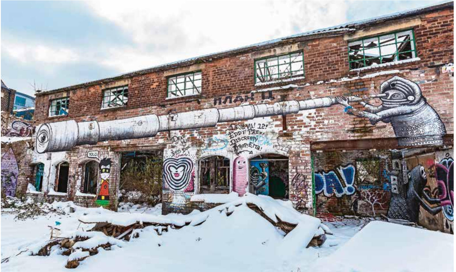
«Tiefe Risse bedrohen den Zusammenhalt in unseren Gesellschaften»: Industrieruine in Paul Colliers Heimatstadt Sheffield.
