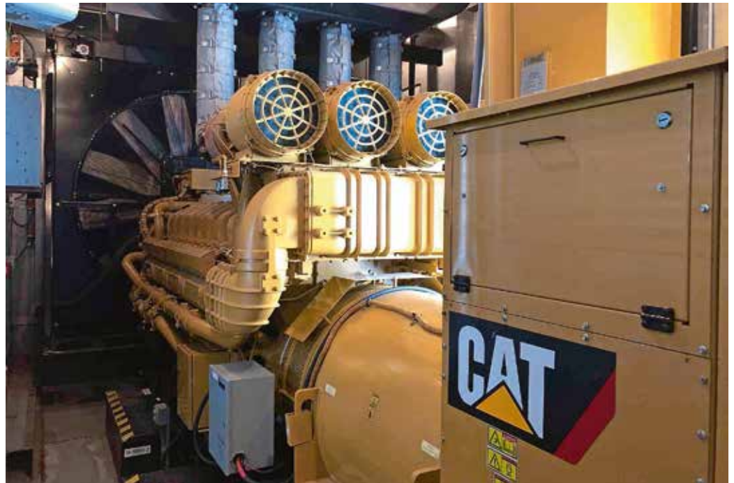
Macht es Viola Amherd in Sachen Zusammenbruch des Stromnetzes besser?
