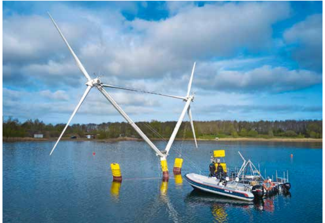
Wir brauchen nur 4000 dieser schwimmenden Inseln: Testkraftwerk «Nezzy» in Hymendorf.
