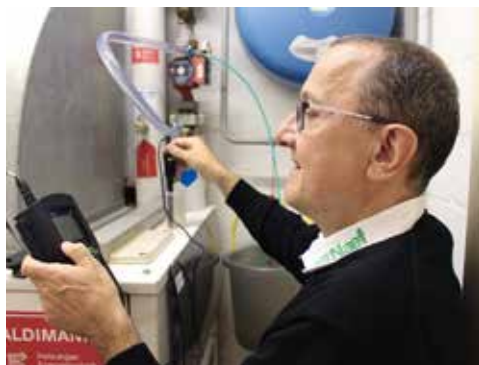
Umfassende Zustandsanalyse vor Ort.
