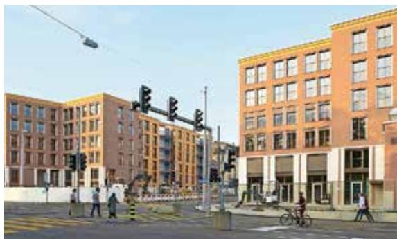
Täuschung der Bürger: Grossüberbauung Hornbach.
