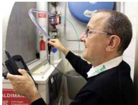
Umfassende Zustandsanalyse vor Ort.
