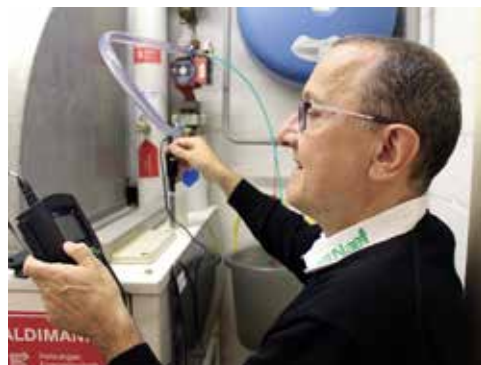
Umfassende Zustandsanalyse vor Ort.
