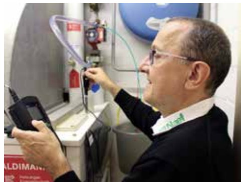
Umfassende Zustandsanalyse vor Ort.
