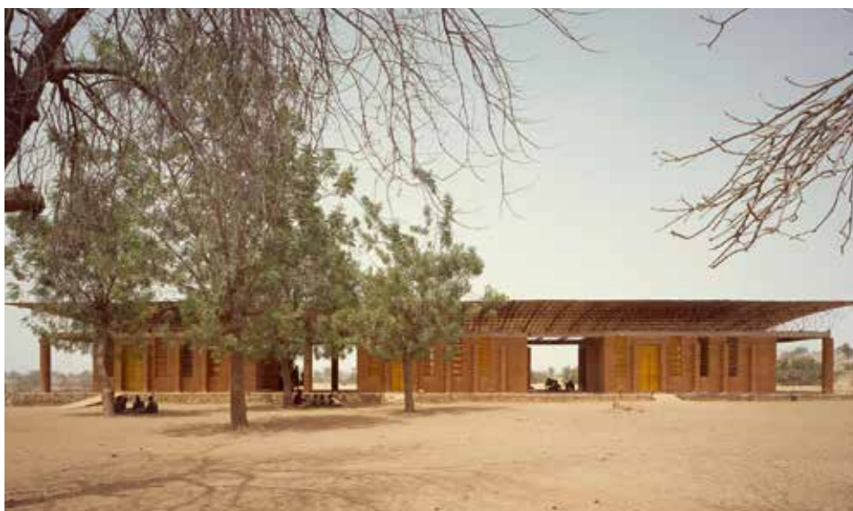
«Jeder verdient Qualität»: Kérés Schulgebäude in Gando.
