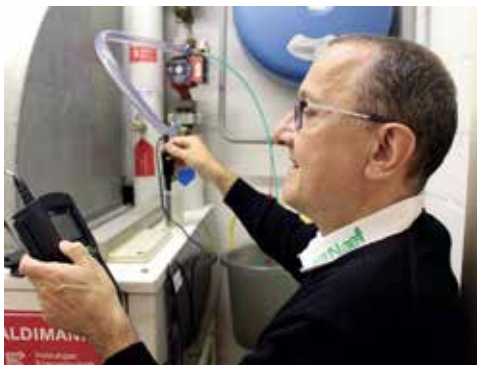
Umfassende Zustandsanalyse vor Ort.
