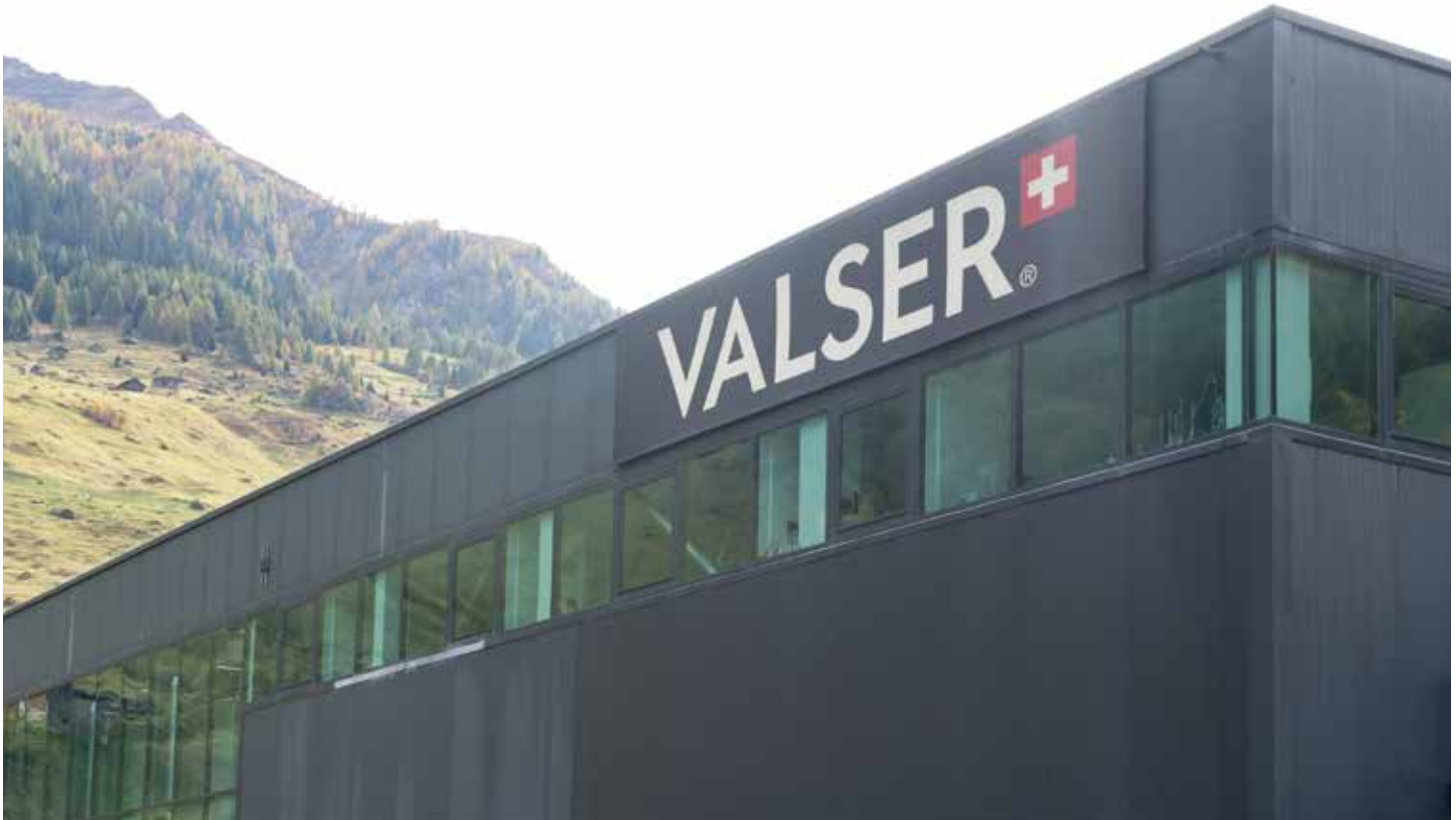
Wasserbedarf massgeblich reduziert: Produktionsstandort in Vals.
