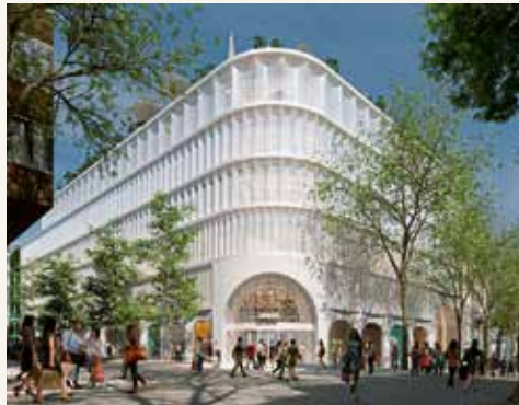
Die Bauarbeiten ruhen: geplantes Luxuskaufhaus «Lamarr».
