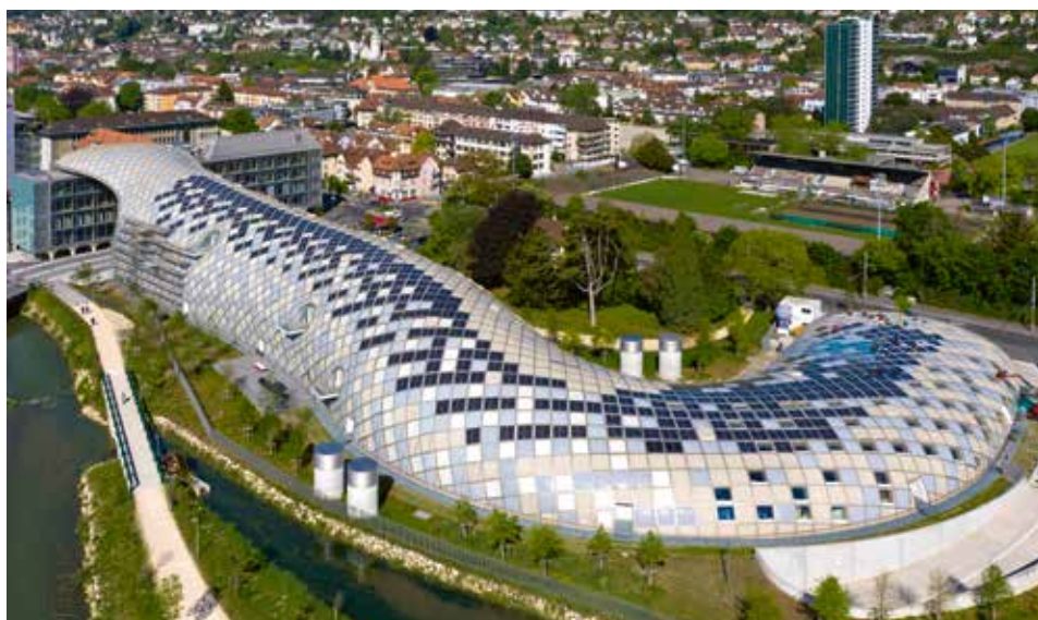
4600 Einzelteile aus Schweizer Fichtenholz: Swatch-Zentrale in Biel.
