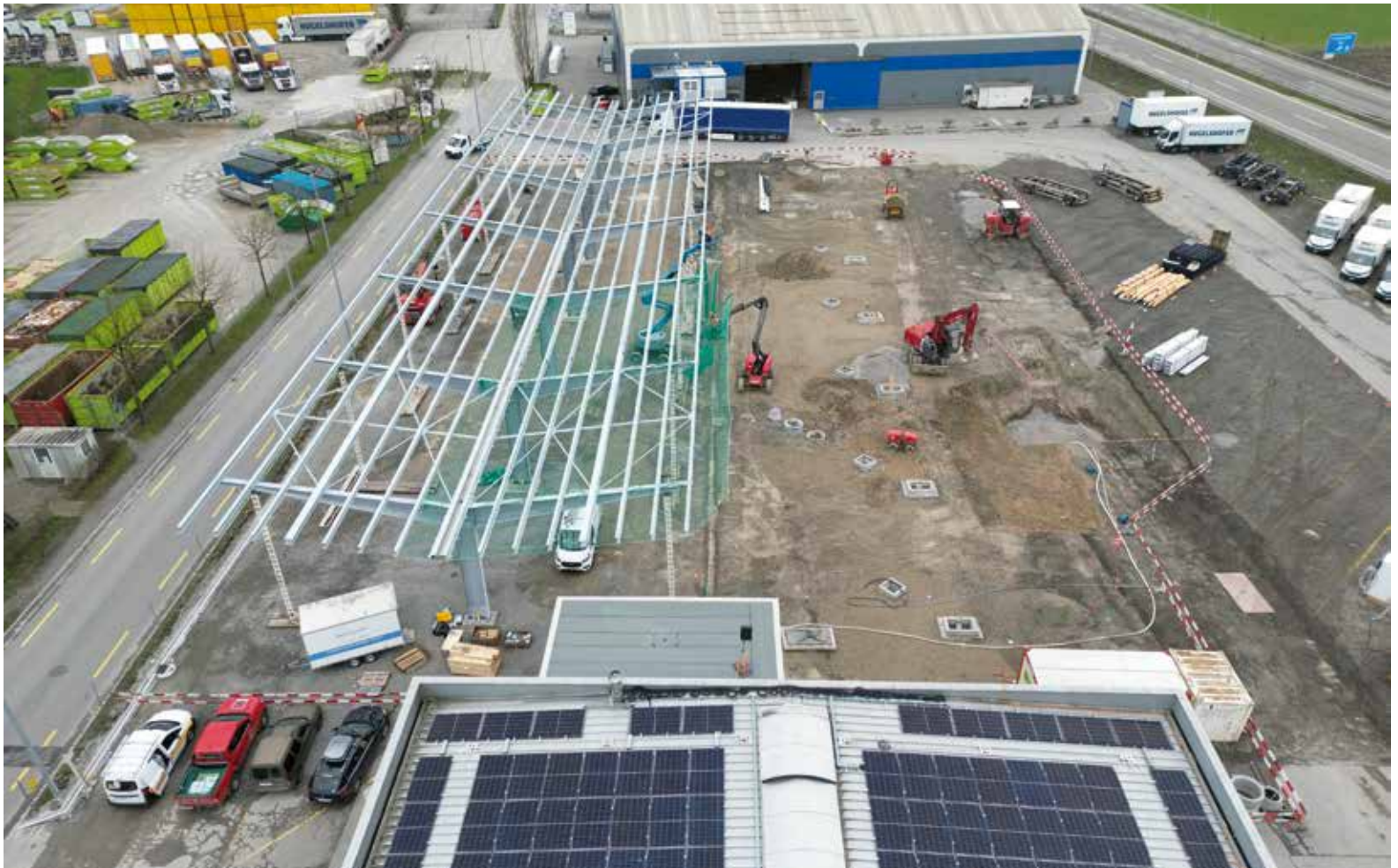
Hier wird an der Zukunft gebaut: Auf dem Gelände in Frauenfeld stehen die Bauarbeiten kurz vor dem Abschluss.
