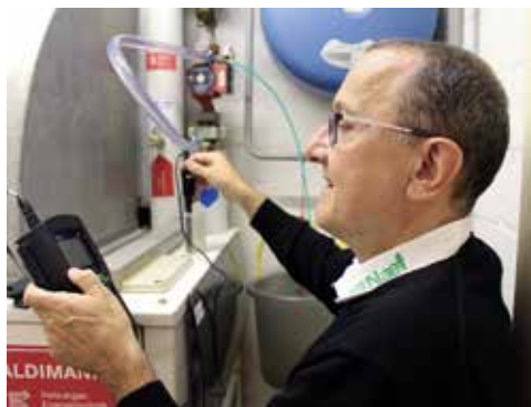
Umfassende Zustandsanalyse vor Ort.
