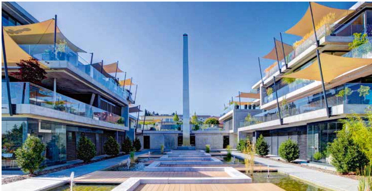
Legomässig zusammengesteckt: Überbauung «Modular» im thurgauischen Uttwil.
