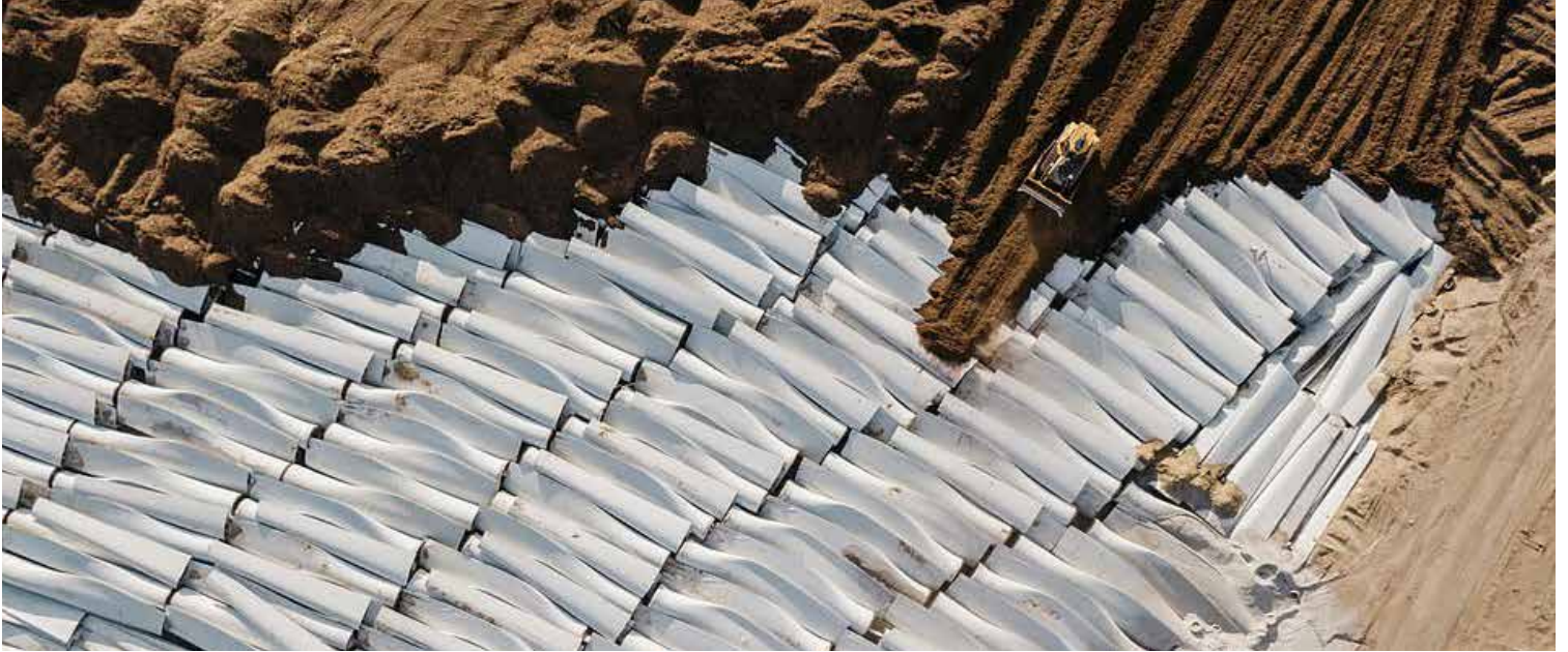
Hohe Kosten für Rückbau und Recycling der Komponenten: Entsorgung von Windturbinenflügeln im Casper Regional Landfill in Wyoming.
