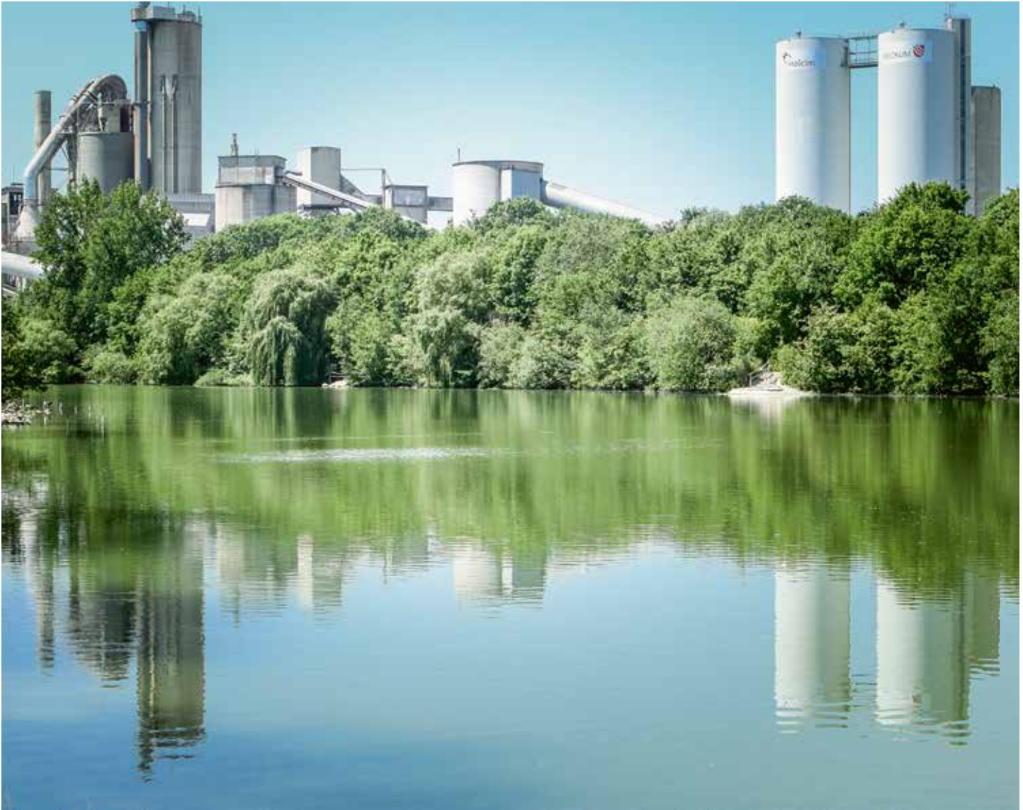
Auch die heute nicht mit vernünftigen Aufwand vermeidbaren Emissionen müssen neutralisiert werden: Zementwerk Beckum.
